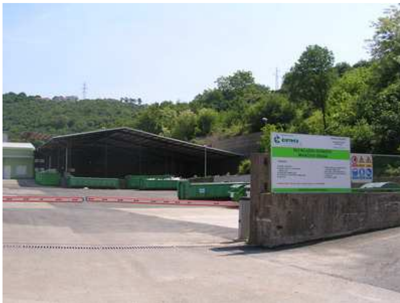
Slika 3. Primjer reciklažnog dvorišta
